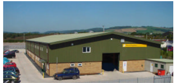
Lo stabilimento della Duncan Propellers Ltd.
